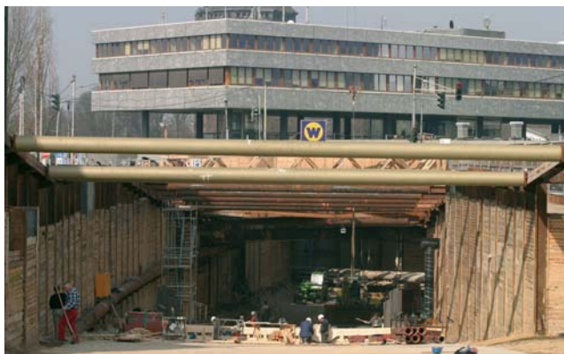
Ein Logistiktunnel verbindet das östliche mit dem westlichen Messegelände
