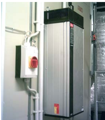
Beispiel eines Frequenzumformers der RLT-Anlage Halle 14 (A1), Lüftungszentrale Süd (links)
