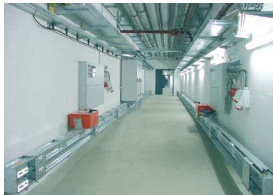
Halle 4 / UG. Technikgang mit der Versorgung der Sparenkanäle
